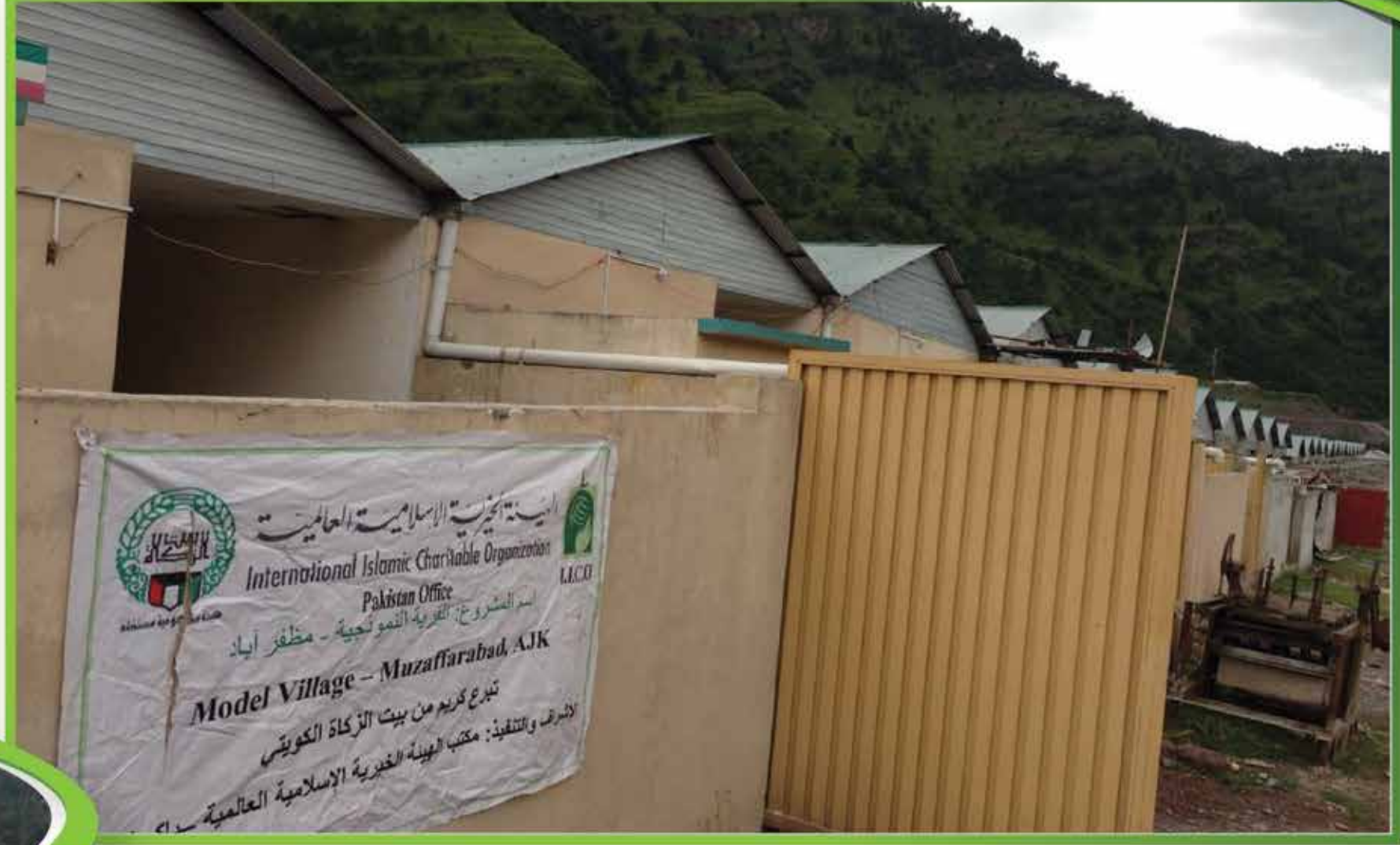
تركيب المرافق والتجهيزات للبيوت
